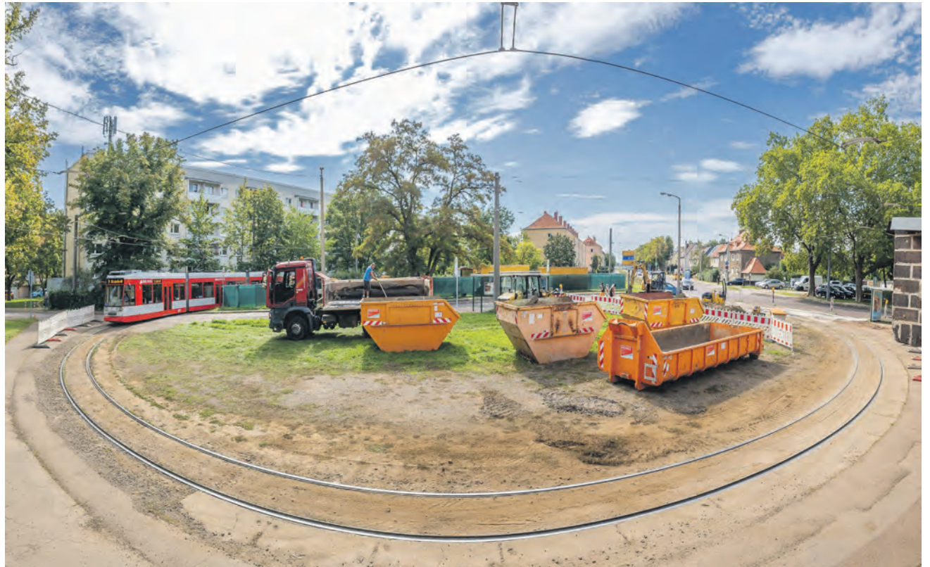
Der geplante Ausbau der Dessauer Straße umfasst den Abschnitt zwischen der Kreuzung Landrain und der Endhaltestelle Frohe Zukunft und schließt auch die Umgestaltung der Wendeschleife ein. Fotos: Thomas Ziegler
